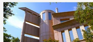
Building 3 - Av. Esplugues
